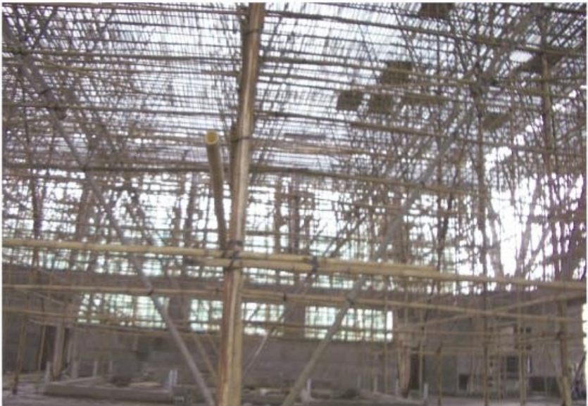
圖片說明 上圖：妙法寺新大雄寶殿佛像已搭好棚架，準備於日內開展佛像鋪金； 中圖：妙法寺外貌斜上的玻璃牆壁甚為美觀； 下圖：建造之時，所搭棚架頗為複雜，也可見得搭棚這中國國粹如何精妙。
